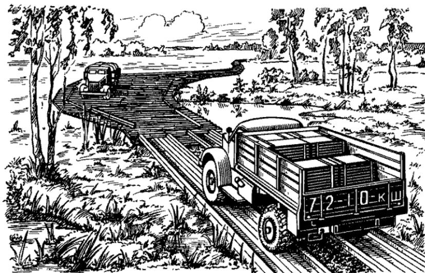
Рис. 26. Движение автомобилей и разъезд по колейной и жердевой дорогам
