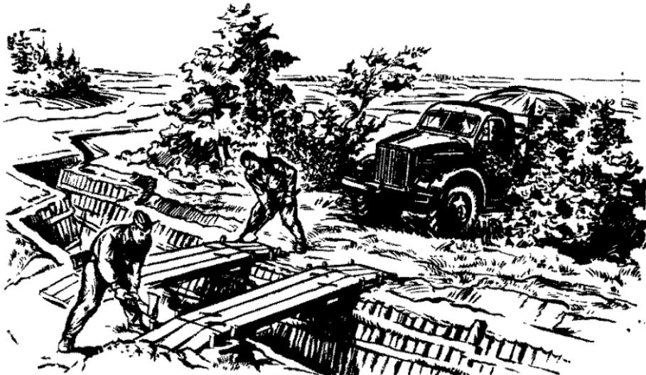
Рис. 25. Установка колейных мостов через траншую
